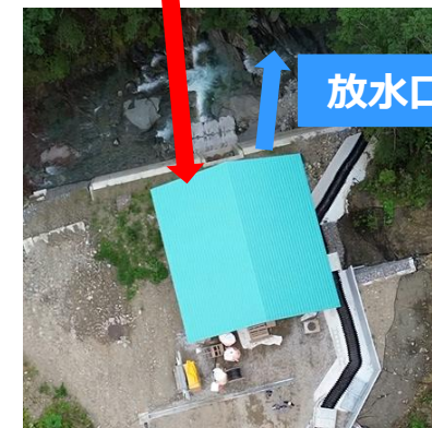
発電所（上空より）
