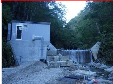
沈砂池及び除塵機
