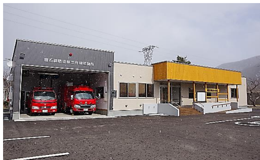
熊石消防署相沼・泊川分遣所
