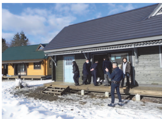
建設中の宿泊施設
