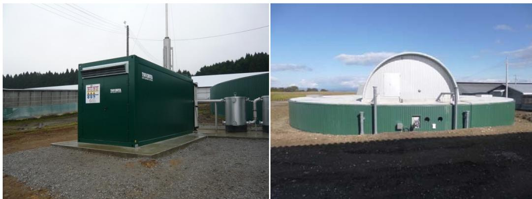
図 3-16 八雲町家畜糞尿バイオガス発電（左：発電機、右：発酵槽）
