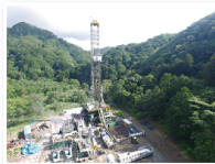
鉛川に設置されたリグ（掘削機）
