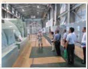
タービン・発電機
